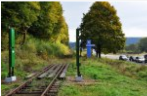
Wyposażenie Kolejowego Przejścia Granicznego Krościenko - Chyrów w bramkę radiometryczną
