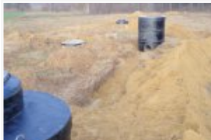
Instalacja przyłączy w Drogowym Przejściu Granicznym Budomierz-Hruszew (prace przygotowawcze)
