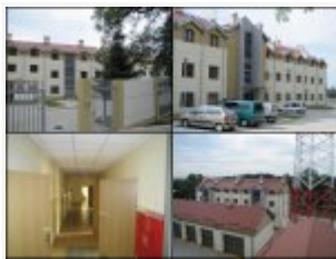
Rozbudowa Placówki Straży Granicznej w miejscowości Horyniec - Zdrój
