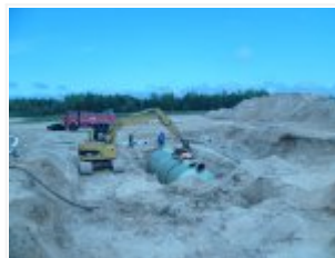
Budowa infrastruktury drogowego przejścia granicznego Połowce-Pieszczałka - zbiornik retencyjno-rozsączający
