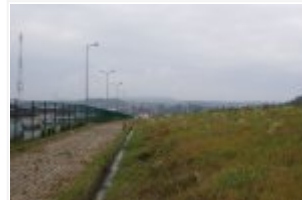
Budowa lądowiska dla śmigłowców na Drogowym Przejściu Granicznym w Hrebennem
