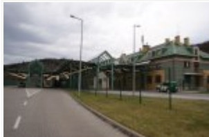
Rozbudowa infrastruktury drogowej oraz zakup sprzętu do kontroli granicznej w Drogowym Przejściu Granicznym Krościenko - Smolnica
