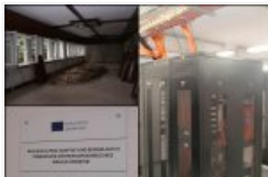
Realizacja prac adaptacyjno-budowlanych pomieszczeń centrum zapasowego oraz wyposażenie w sprzęt IT
