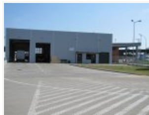
Przebudowa budynku kontroli szczegółowej na wjeździe i budowa budynku kontroli szczegółowej na wyjeździe w Drogowym Przejściu Granicznym Medyka - Szeginie
